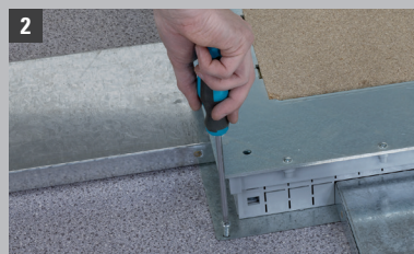
2 Вставить кабель-каналы и привинтить к полу
