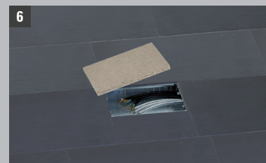
6 Снять защитную заглушку
