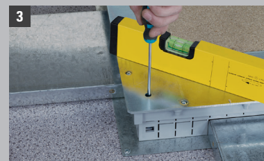
3 Отрегулировать с помощью винтов
