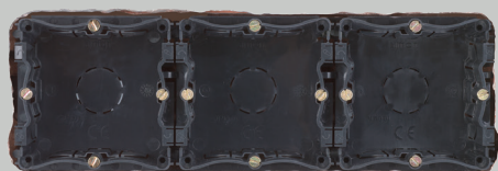
Установка механизмов Simon 82
