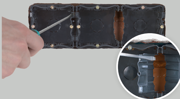
Установка механизмов Simon 82 Centralizaciones
